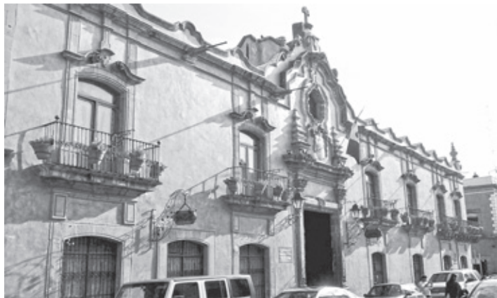
Hotel Casa de la Marquesa. (GSH, 2012).
