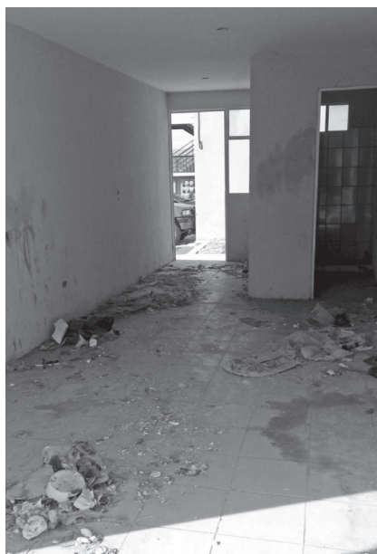
Figura 8. Vivienda abandonada en Valle de San Pedro.
